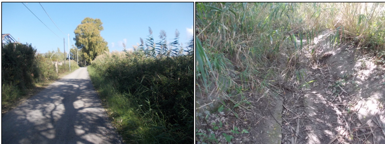
Figura 4.5: Canale_56411 a valle dell'area in studio e immediatamente a valle del ponticello, nella foto di sinistra il canale corre sulla destra della strada l'area in studio invece si trova sulla sinistra, nella seconda foto si vede l'alveo del canale rivestito in lastre di cls.
