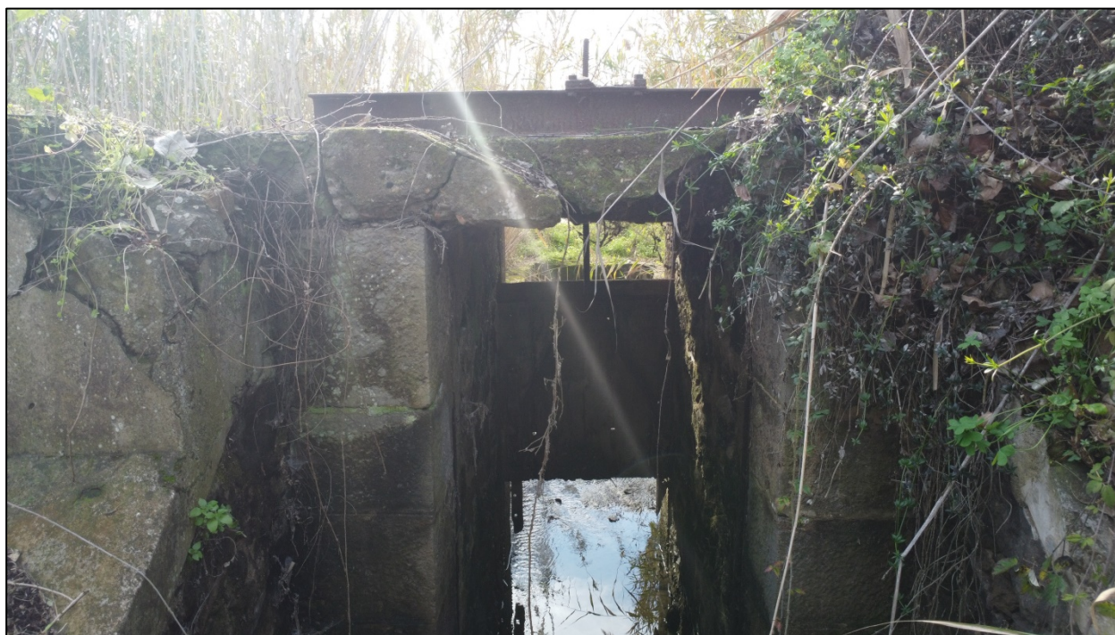
Figura 4.10: Particolare della paratoia mobile dell'opera idraulica tra il Canale_56411 e il Rio Mannu di Pula
