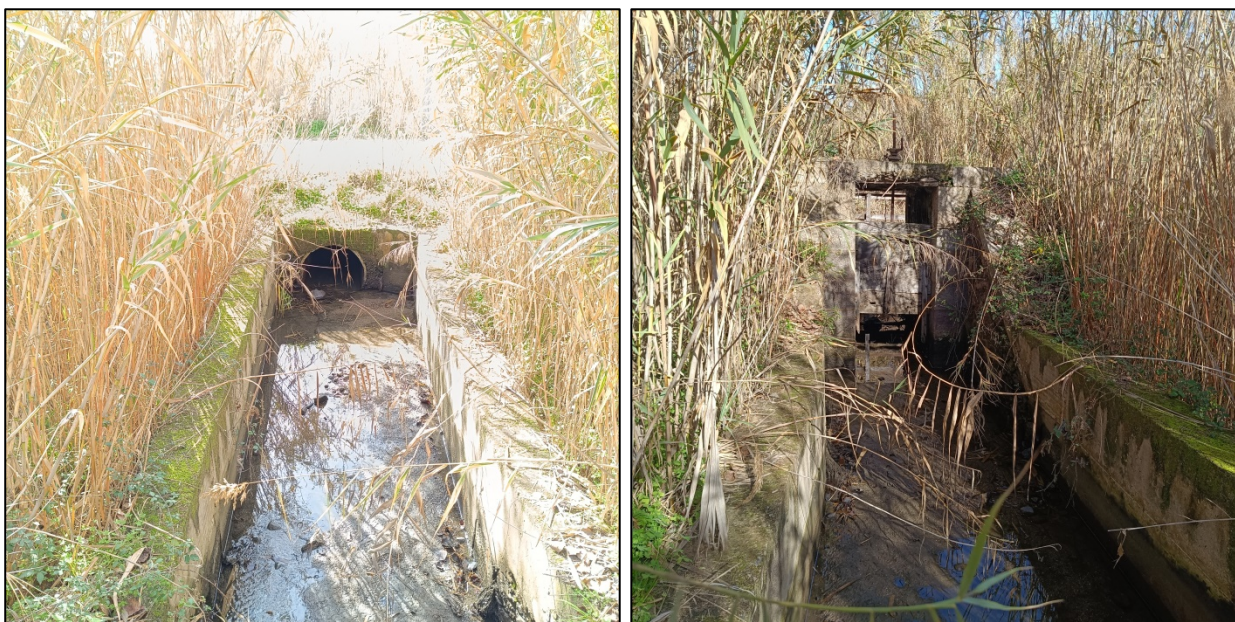
Figura 4.8: Tratto terminale del Canale_56411 in prossimità della confluenza con il Rio Mannu di Pula rispettivamente in prossimità del tombino sul Viale Segni e dell'opera idraulica sugli argini del Rio Mannu di Pula.
